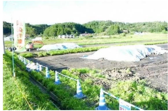
写真6 除染土の仮置き場。フレコンバックにシートが被せられている。しかし、その背後の山林の除染は進まない。
