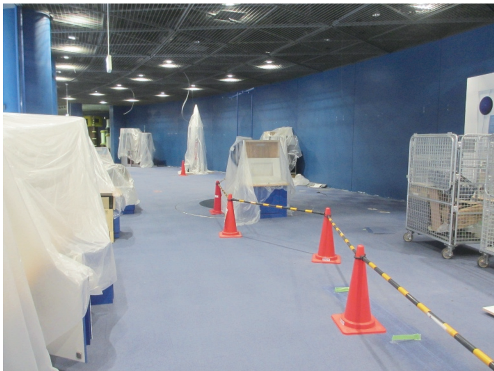
工事中の科学館展示場4階
