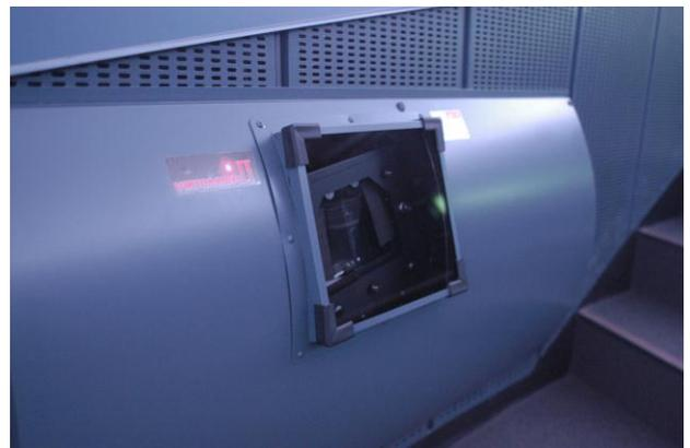
**写真: 新しいプロジェクターカバー。光が通る部分を旧来のアクリル曲面カバーから平面ガラスカバーに変更している。**
