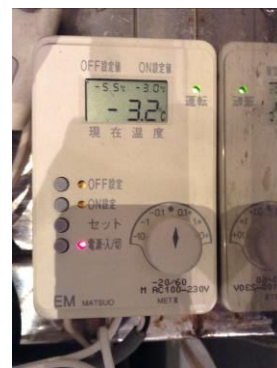
図11. サーモスタットの設定温度は最終的に-6.5~-3.0°Cがもっとも良かった。表示される庫内温度は-3~-4°Cでキープされていた。
