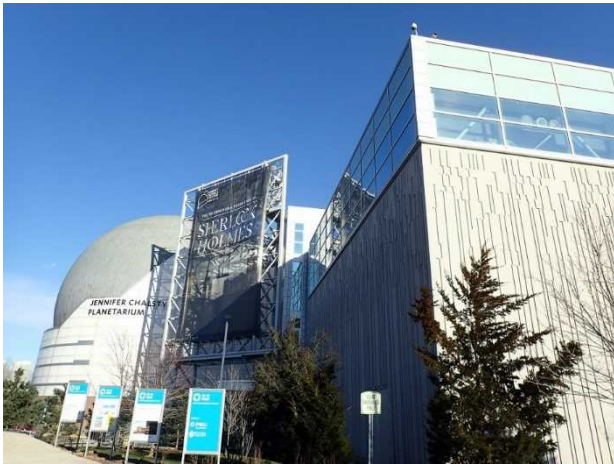
写真 7-4. リバティーサイエンスセンター
