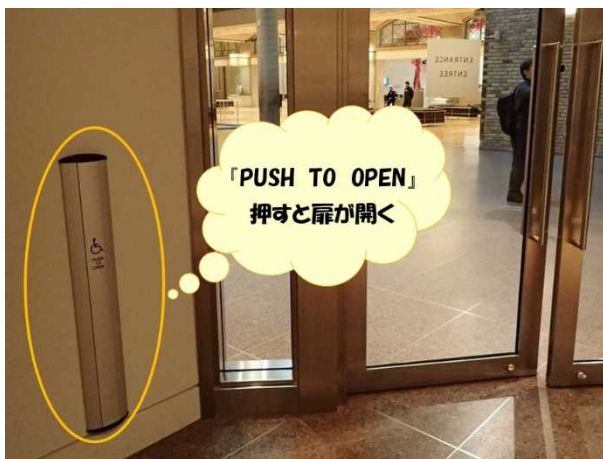
写真 7-1-2. 車いすマークのボタンを押すと扉が開く
