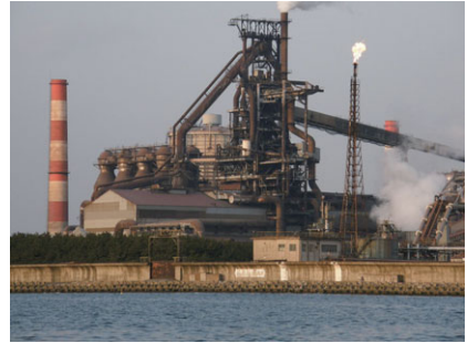
写真1 高炉(加古川製鉄所)
