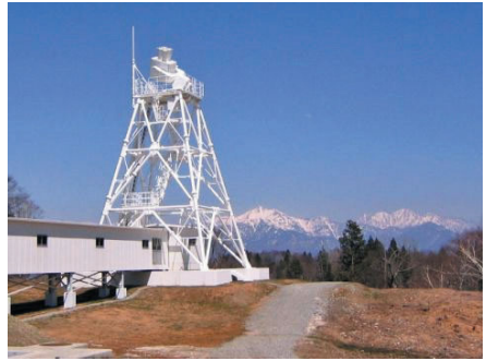
図9: 16mの高さに設置されている25cm望遠鏡2本と20cm望遠鏡2本からなるSMART望遠鏡。H \alpha 線での太陽撮像と磁場を測る観測をしています。
