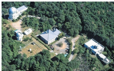
図1:現在の花山天文台の航空写真。左上が本館、その下のドームのある建物が別館、その右上隣に四角い木造平屋建ての歴史館、図の中央に新館、図の右下に太陽館があります。左上が北です。
