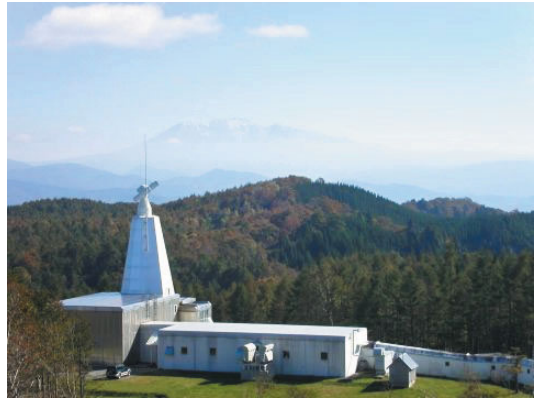
図8: 北アルプスを背景にしたドームレス太陽望遠鏡。塔の上、地上から高さ25mのところ、口径60cmの望遠鏡が置かれています。
