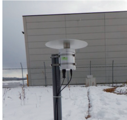
図4 雷放電観測用のアンテナ
