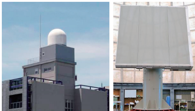
図7 大阪大に設置されているフェーズドアレイレーダ
