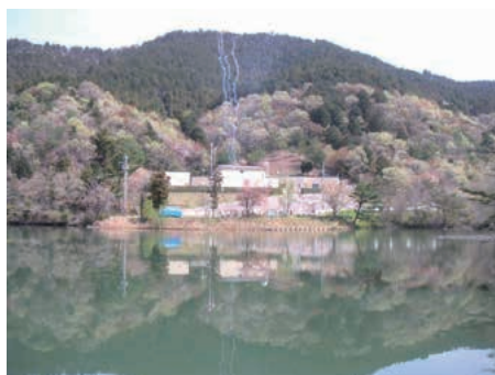
図5. 現在の検査所(愛知県豊橋市)
