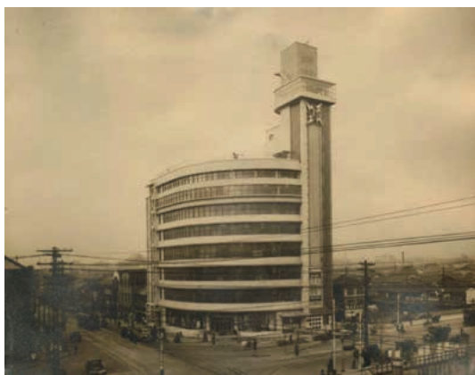
図1. 開館当時の電気科学館
