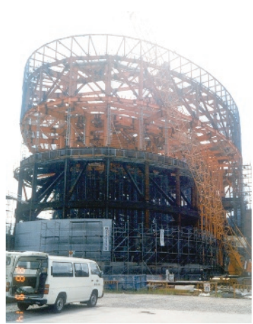
写真1:建設中の科学館(1988年)
