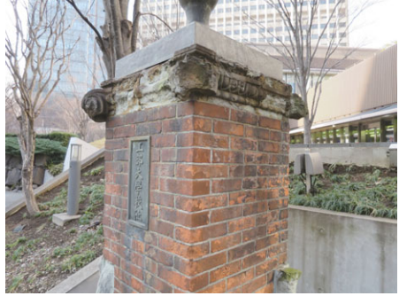
工部大学校跡
