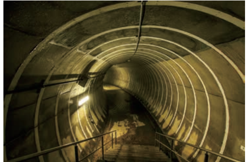
写真2. 湊川隧道の転流坑
