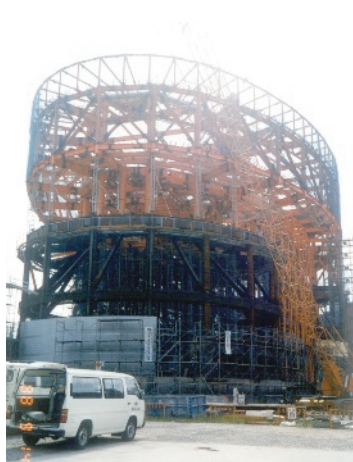
写真1:建設中の科学館(1988年)
