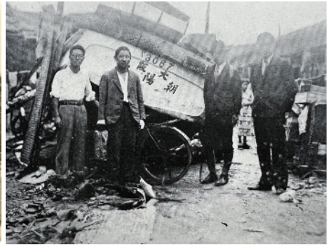
図6. 大阪支台観測船朝陽丸の被害
