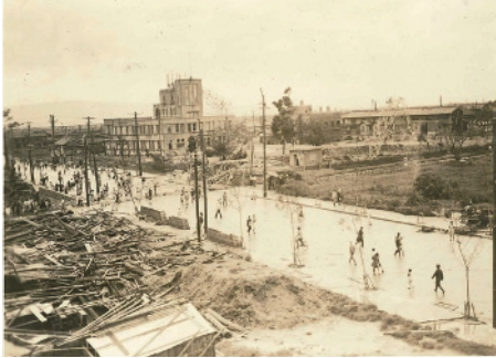
図5. 府立大阪測候所鉄塔3基倒壊
