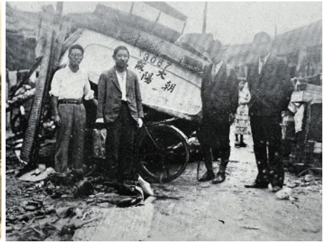
図6. 大阪支台観測船朝陽丸の被害
