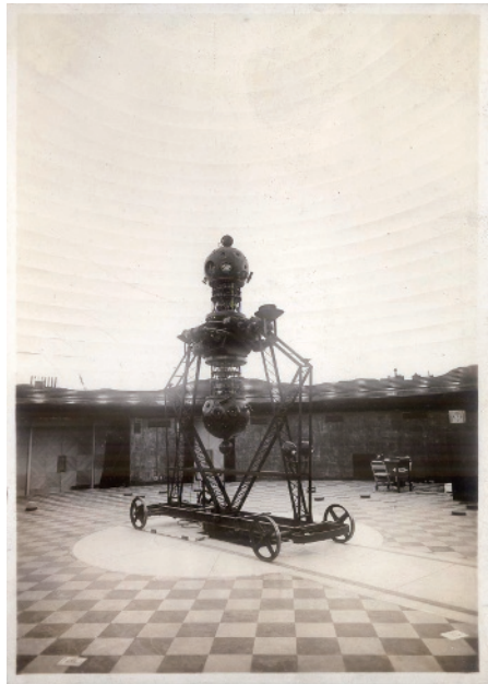
写真4. 組み立て中のツァイスⅡ型プラネタリウム。1937年2月頃の撮影。
