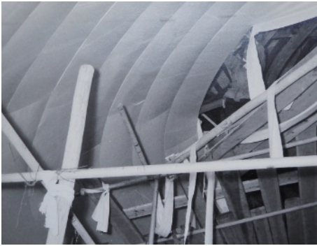
写真3. ドームスクリーンのリネン張り作業。1961年の張替え時の様子。
