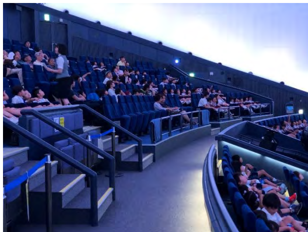
図 14 従来の通路足下照明
