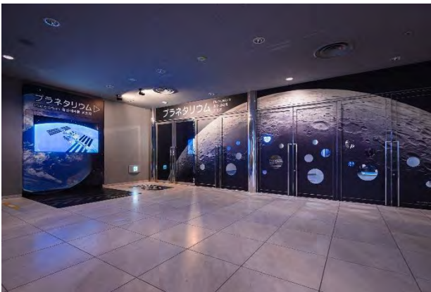
図 18 アトリウムとプラネタリウムを仕切る 8 面の扉。月の巨大な写真を、フレームも含め全体にはめ込んだ、安全対策で向こう側が見えるように穴をあけている。
