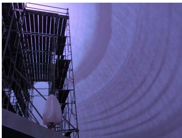
図 22 ドームスクリーン清掃のためくみ上げた足場
