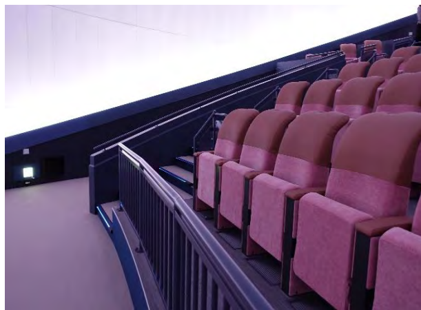
図 12 最前列のイスと通路。通路から段があがったため転落防止柵を設置した
