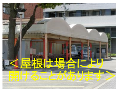
西側 自動販売機前テント
