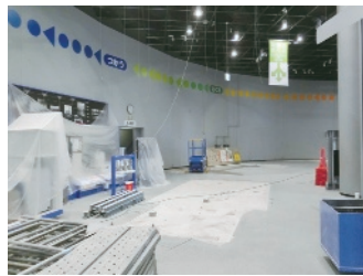
工事中の展示場
