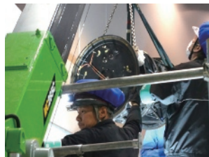
写真3. 惑星棚の取り外し
