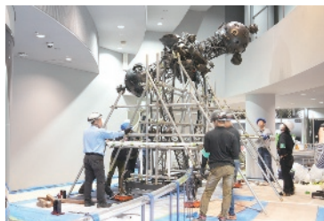
写真1. 足場の組み立て
