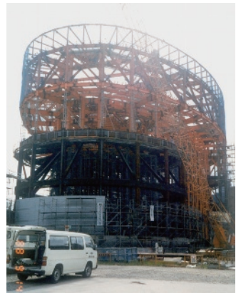
写真10. 建設中の科学館 (1988年9月撮影)
