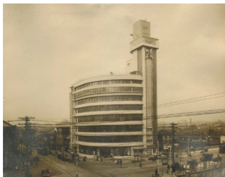
写真1. 開館当時の電気科学館 外観
