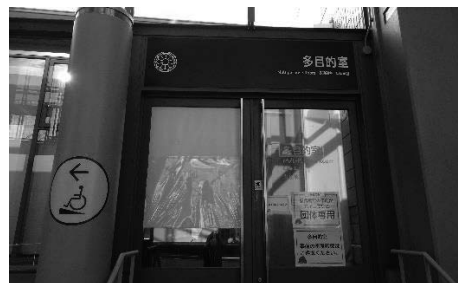
写真 19. 多目的室 階段側入口
