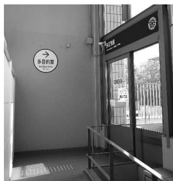
写真 20. 多目的室 スロープ側入口
