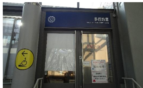
写真 19. 多目的室 階段側入口
