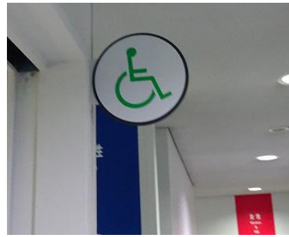
写真 24. 多機能トイレ突き出しサイン(展示場4階) 突き出しサインを付けて視認性を高めた。
