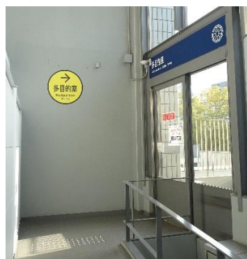
写真 20. 多目的室 スロープ側入口
