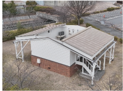
移築された旧倉敷天文台 スライディングルーフ観測室
