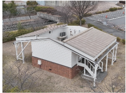
移築された旧倉敷天文台 スライディングルーフ観測室
